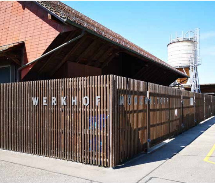
Die Hauptsammelstelle beim Werkhof an der Gossauerstrasse 21, welche 2017 neu gestaltet wurde
