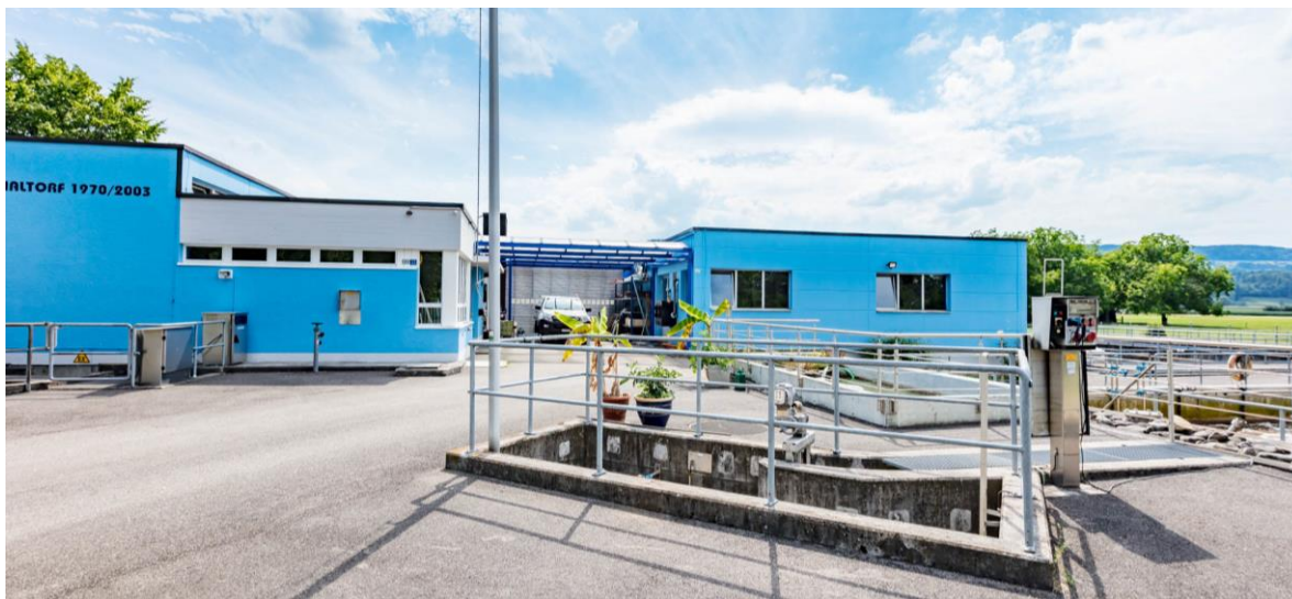
Kläranlage Mönchaltorf - Seestrasse
