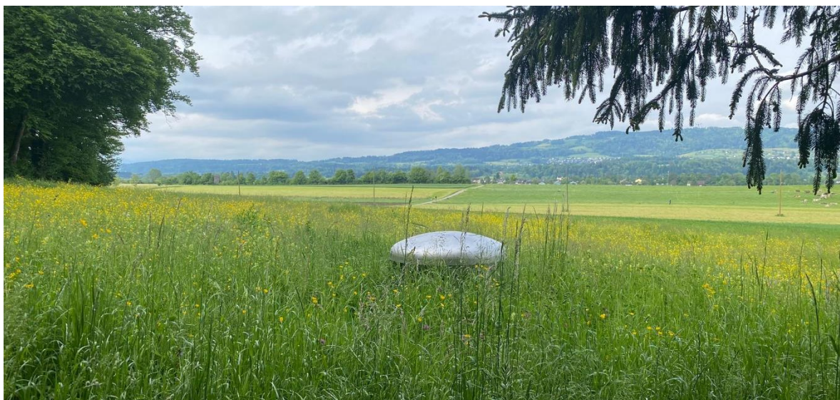
Örtlichkeit der Quellableitung, die ersetzt werden muss
