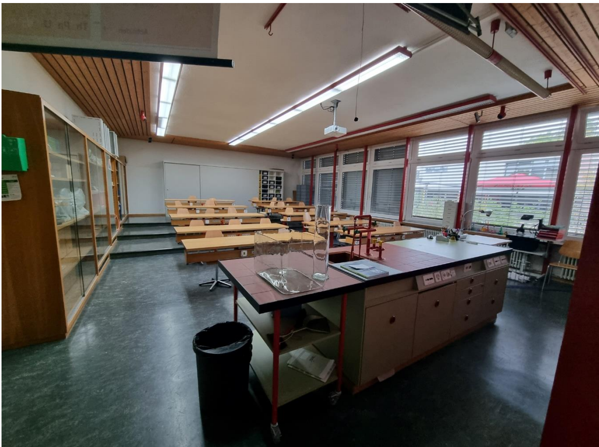
Heutiges sanierungsbedürftiges Naturkundezimmer
