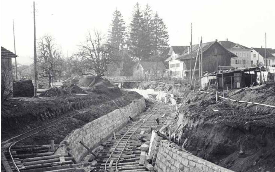
Aabachtieferlegung im Dorf (Bild ALN)
