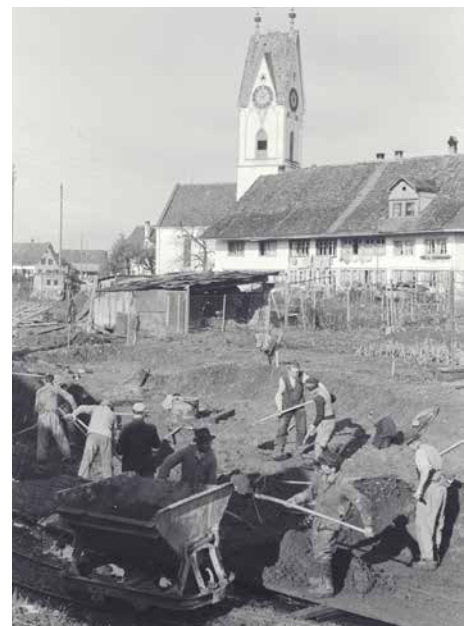
Die Bachsohle wird tiefergelegt (Bild ALN)
