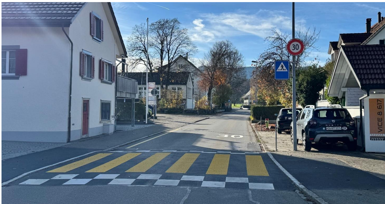
Flache Anrampung auf 30er-Strecke Rällikerstrasse
