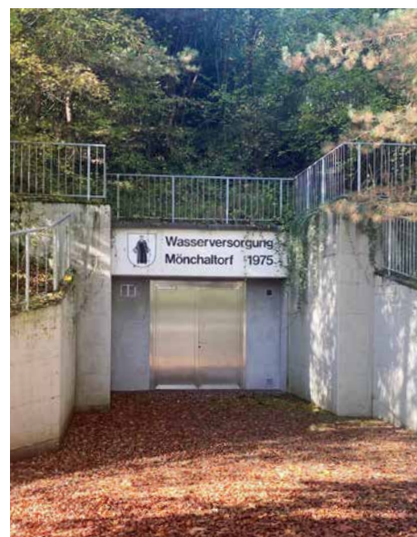
Trinkwasser Reservoir Oberfospel, Mönchaltorf
