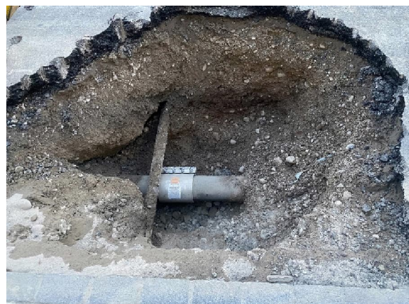
Reparatur Wasserrohrbruch Usterstrasse
