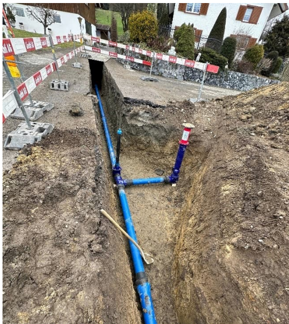
Ersatzneubau Trinkwasserleitung Wüeri
