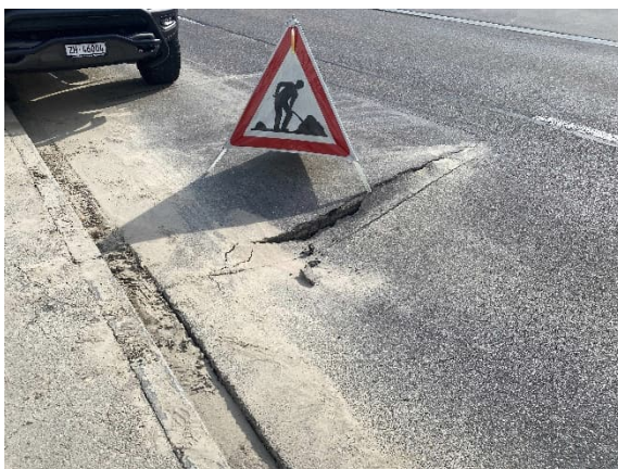
Wasserrohrbruch Usterstrasse
