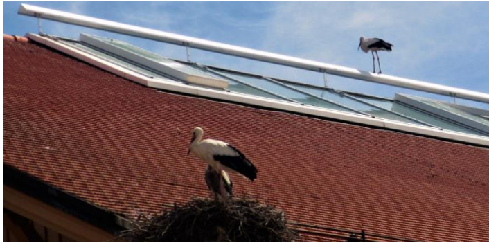
Ein Giebelaufsatz verhindert Horstbau auf Dachfenstern und Sonnenkollektoren. Ein horizontal straff gespannter Draht verhindert das Landen der Störche.
