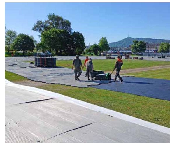
Der Boden muss geschützt werden, insgesamt wurden über 15'000m 2 Bodenschutz verlegt
