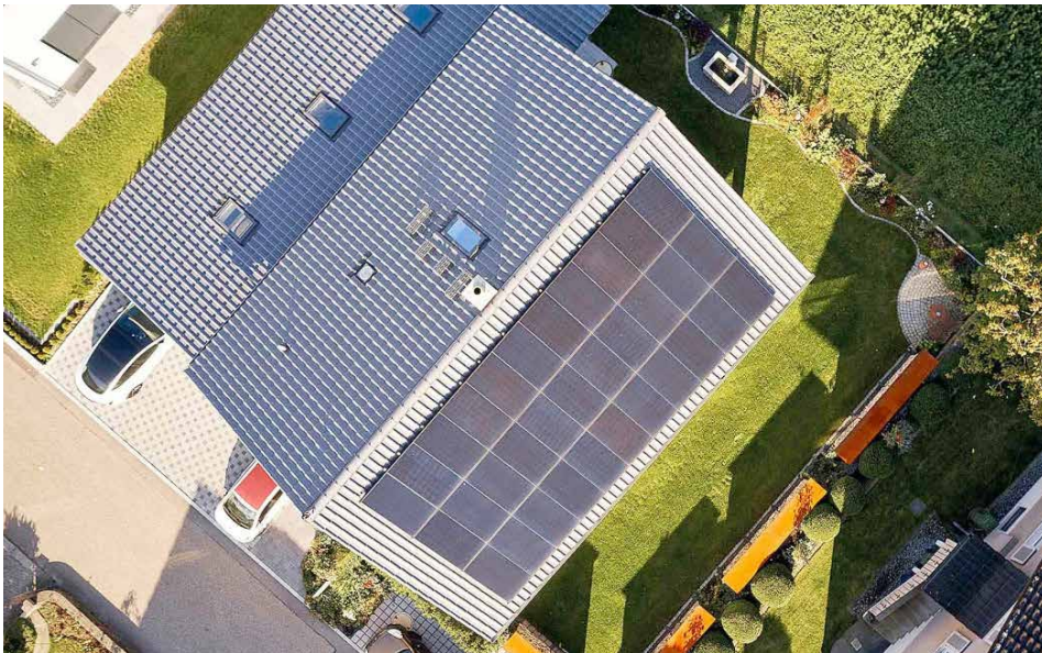
Eine PV-Anlage lohnt sich insbesondere bei einer gleichzeitigen Dachsanierung. [www.ckw.ch]
