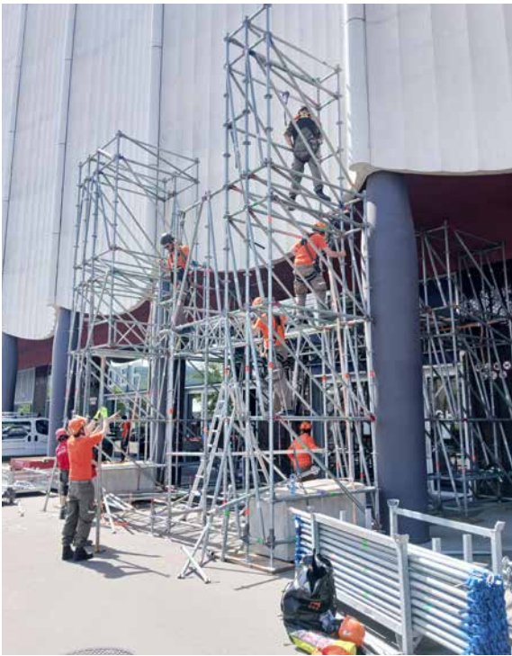
Gerüstarbeiten an der Hockey-WM unter Anleitung und Einhaltung der Sicherheitsvorschriften
