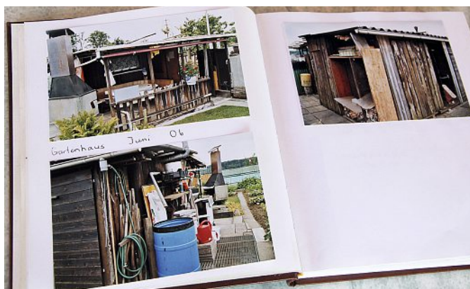
So sah das Häuschen im Schrebergarten vor dem Umbau aus.
