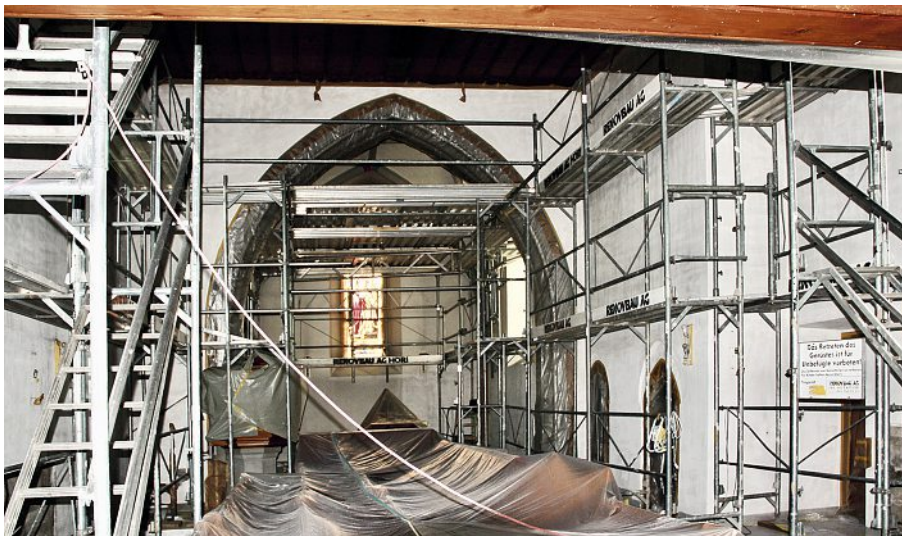
Der Kirchenraum während der Renovation im Sommer 2020. (Foto: Peter Schlumpf)
