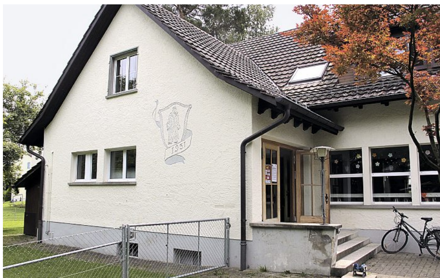
Der 1951 gebaute Kindergarten in Mönchaltorf wurde bis in die 1970er Jahren mit Kohle geheizt
