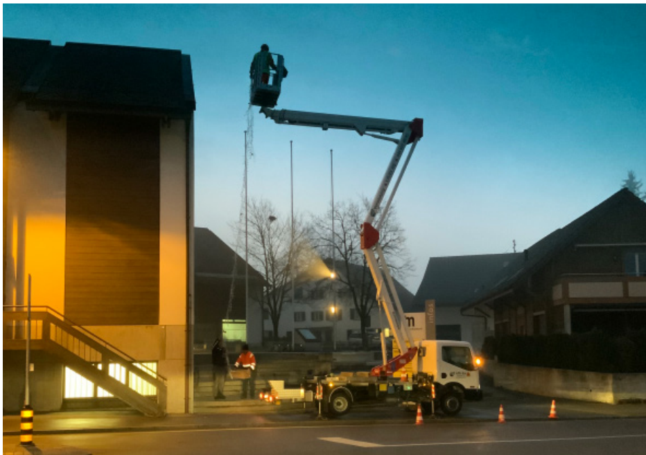
Arbeit in luftiger Höhe: Um die Lichterketten anbringen zu können, wird eine Hebebühne benötigt.
