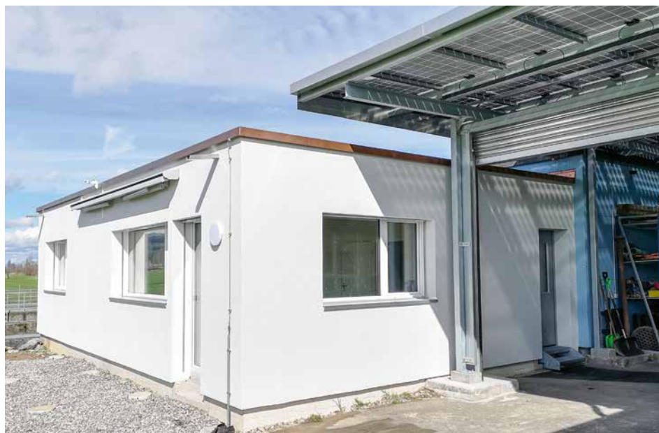
Aussenansicht des neuen Betriebsgebäude-Anbaus sowie der neuen Umschlagsplatz-Überdachung.
