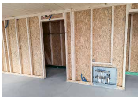
Rohbau Innenansicht mit Elementholzbauwänden, Hartbetonbodenbelag und Bodenheizungsverteilung.
