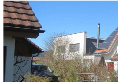
Negativbeispiel im gestalterischen Umgang (Hanflandstrasse)
