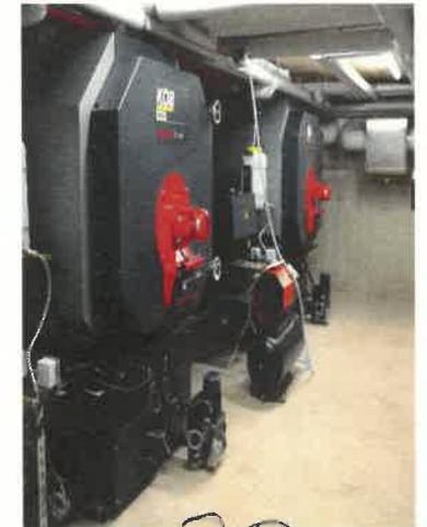
Von Mitte August bis Anfang Dezember 2014 wurde die neue Holzpellet-Heizung in die Räume der alten Ölheizung in der Schulanlage Rietwis eingebaut. Die Aufbereitung des Brauchwarmwassers erfolgt im Sommer durch die auf dem Dach montierte Solaranlage.
